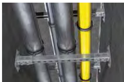
Installazione tubazioni su via di fuga
